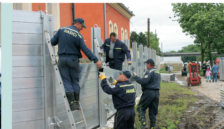
Stavba mobilní stěny
